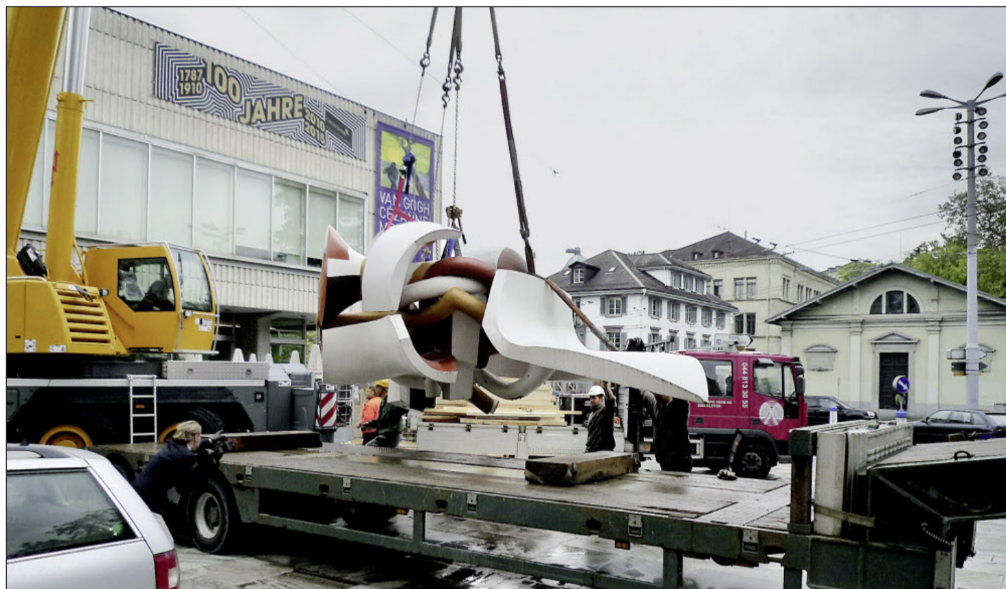
Der Abbau vor dem Kunsthaus in Zürich: Ein Kran hievt den 12 Tonnen schweren Betonkopf der «Fanfare» auf einen Sattelschlepper.
